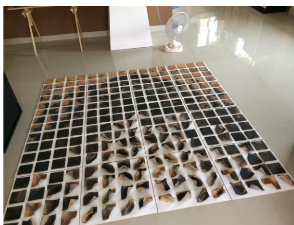
ภาพประกอบ 22: การจัดวางกระเบื้องดินเผาลงบนแผ่นไม้พร้อมติดตั้ง
